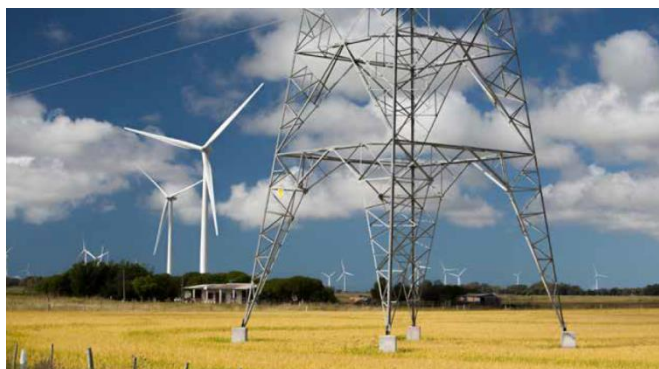
Figura 01 – Foto do Complexo Eólico Campos Neutrais, origem da energia transmitida pela TSLE.
