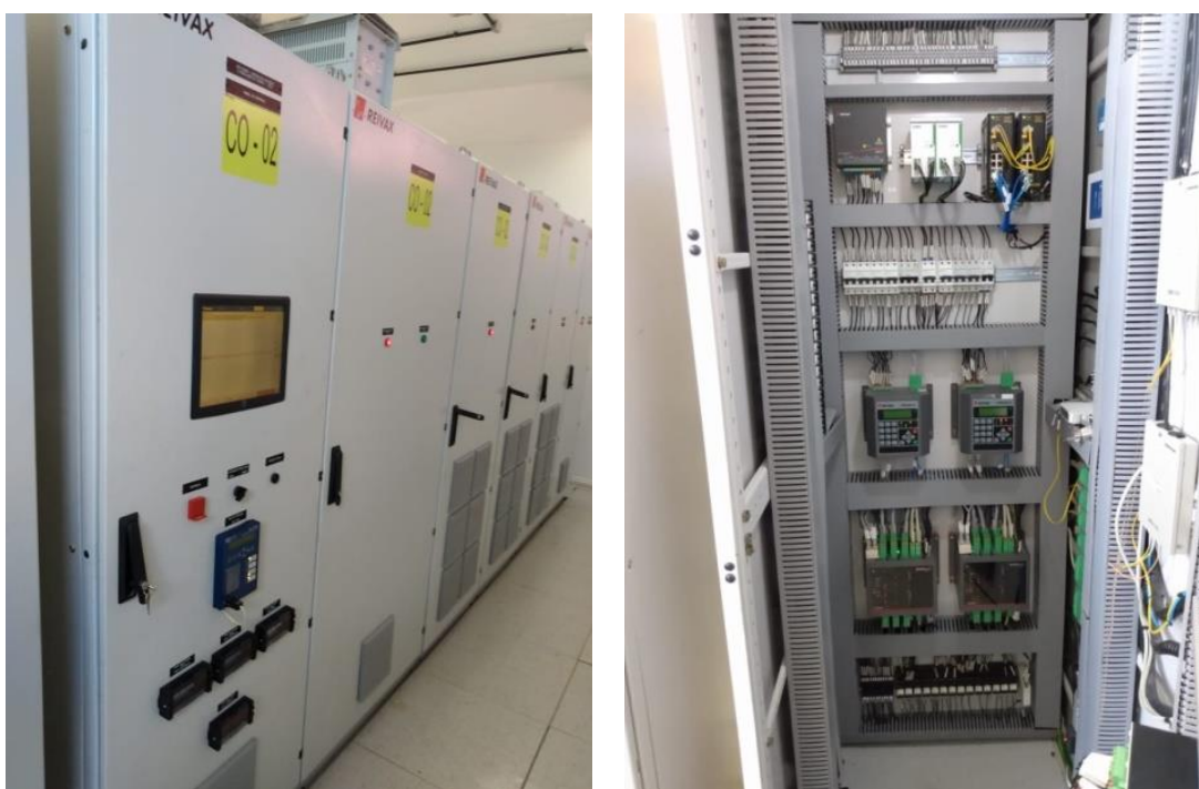
Figura 15 – Vista em perspectiva do sistema de excitação de Marmeleiro 2.
