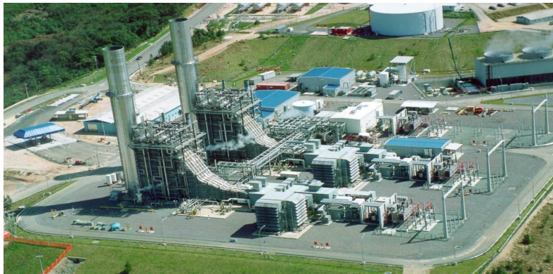
FIGURA 2 – Vista geral da UTE Araucária
