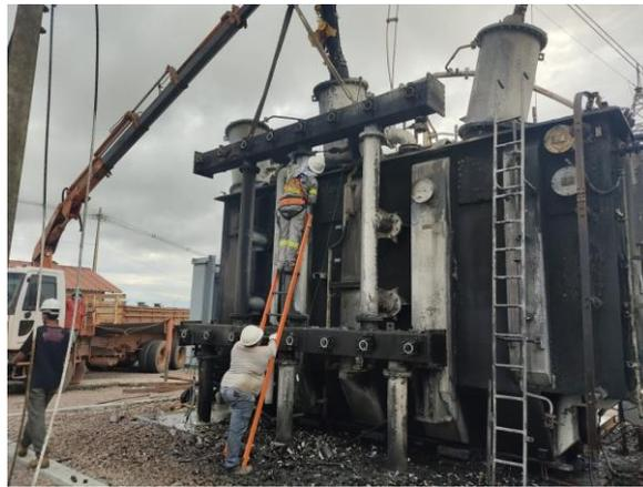
Figura 6: Transformador que sofreu incêndio em subestação do Amapá. Fonte: [4].
