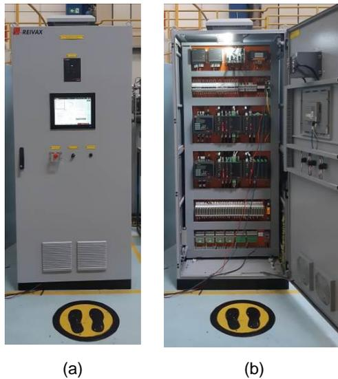
Figura 9: Visão geral do RTVX POWER: a) Painel de controle (vista externa); b) Painel de controle (vista interna).
