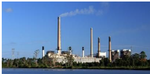
Figura 3: Complexo Termelétrico Jorge Lacerda. Fonte: [4]
